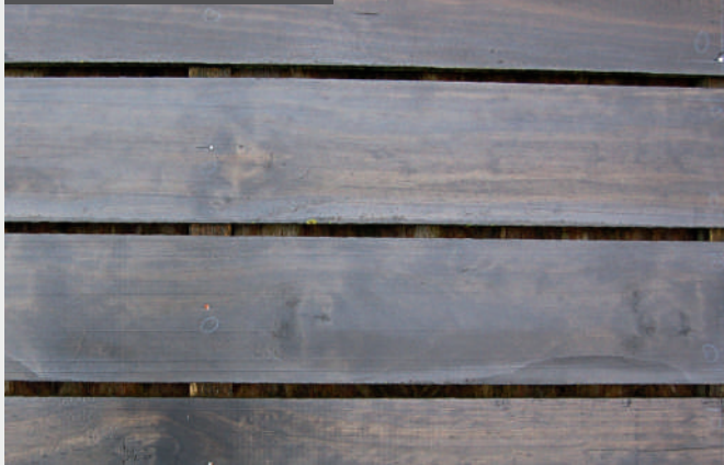
Gevelbekleding uit Accoya® hout
